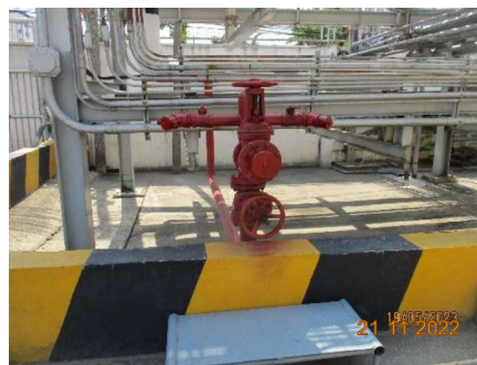
ภาพที่ 2-13 การติดตั้งอุปกรณ์ระบบเหตุอัคคีภัยบริเวณต่างๆ ของโครงการ ทั้งในพื้นที่คลัง และบริเวณท่าเทียบเรือของโครงการฯ
